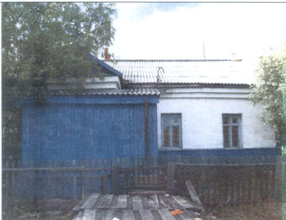
Общий вид здания архива с востока.
